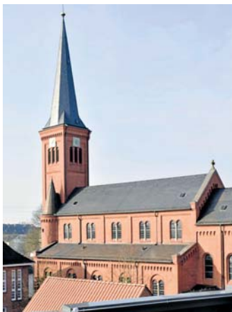
Fast auf den Tag genau vor 125 Jahren wurde mit dem Bau von St. Maria-St. Vicelin begonnen.
