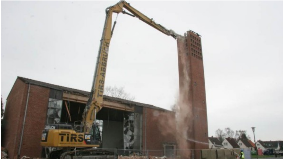
Stück für Stück „knabberte“ Baggerfahrer Holger Diestel gestern mit seinem Langarm-Bagger den Turm der Heilig-Kreuz-Kirche am Veilchenweg herunter. Foto: Vaquette
